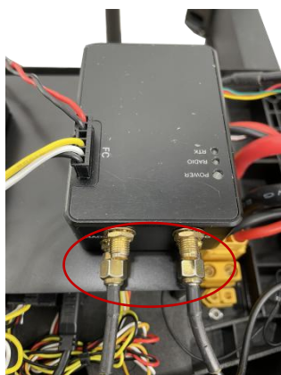
19：RTK 天线线束接在 RTK 上。
